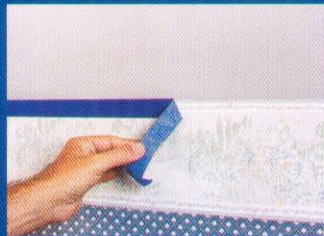
No deteriora el empapelado
